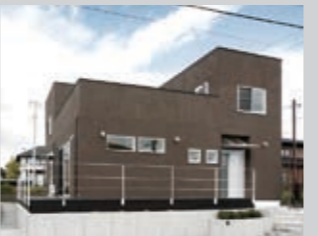
外壁材は店舗などによく使われるジョリパットで、厚みのある仕上がりに
