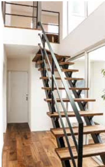
踏み板に木を組合せた鉄骨のスケルトン階段。空間に開放感と明るさをもたししてくれる
