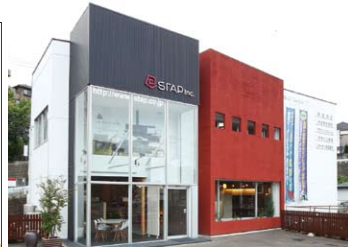
「STAP shop」は仙台泉線沿い。泉中央方面に向かって左手。ガラス張りのこの外観が目印。家づくりに使用する自然素材についての勉強会も開催しているので、詳しくは問い合わせ
